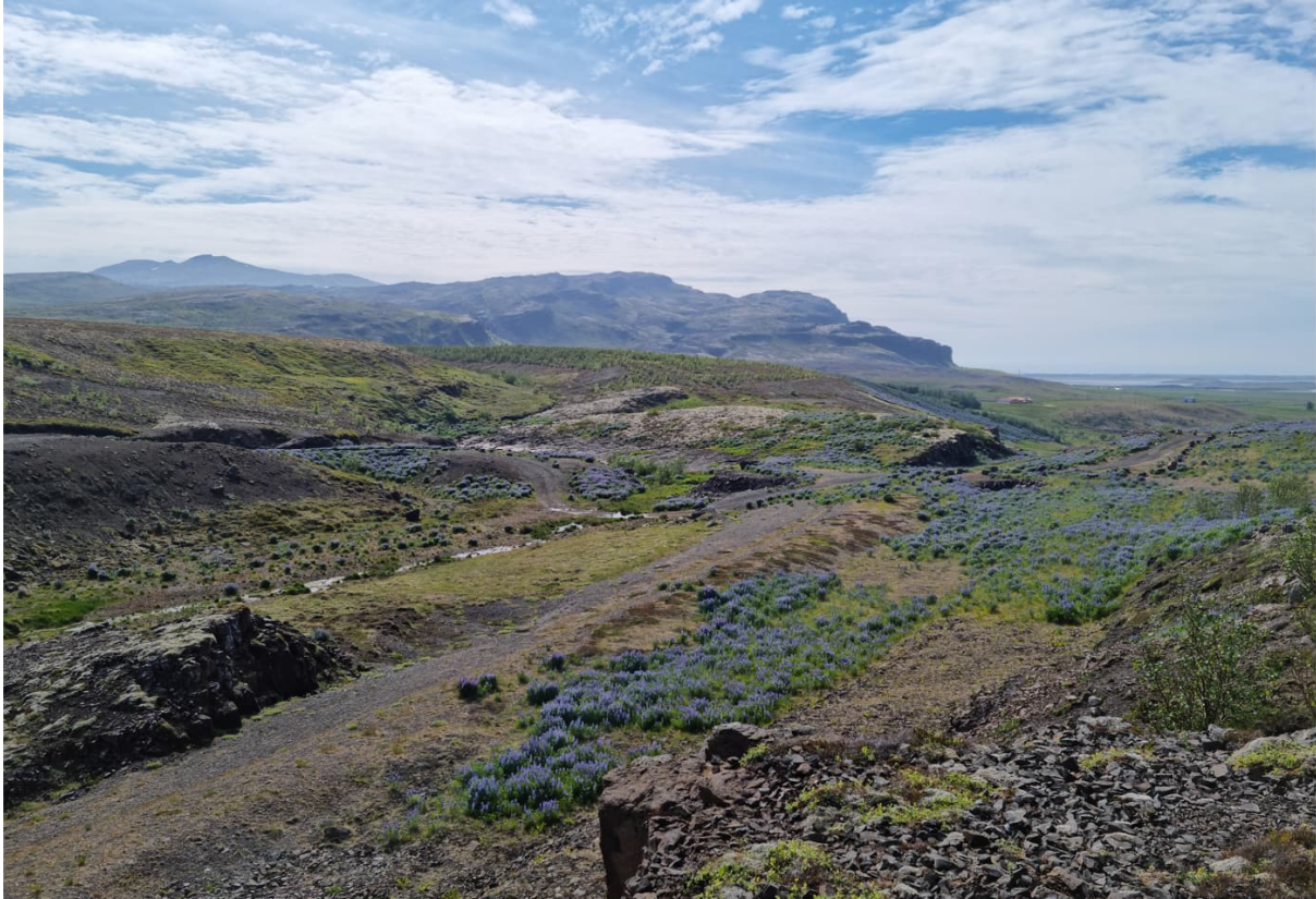
Mynd 7 Horft yfir hluta svæðisins þar sem haugsetja á botnset úr lóni Andakílsárvirkjunar.
