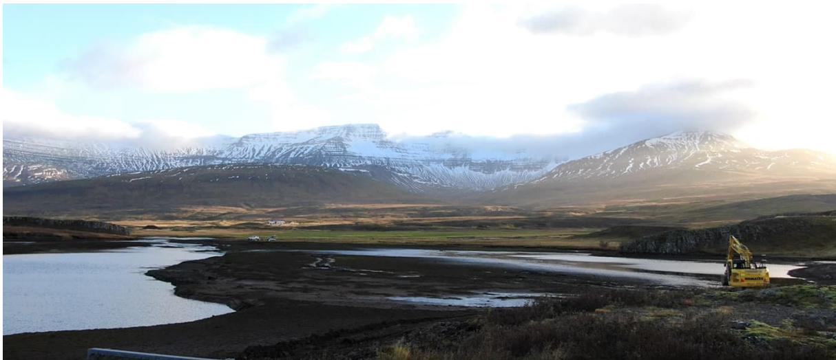
Mynd 8 Horft til suðurs af inntaksstíflunni yfir fyrirhugað varnarstíflustæði við lækkaða vatnshæð þannig að setið stendur uppúr.
